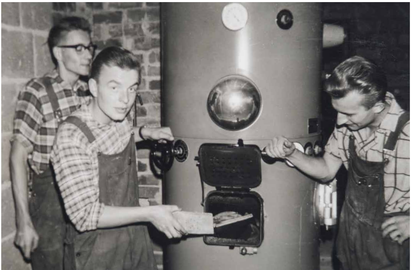
Der junge Klaus Rahn im Einsatz! Hier 1959 mit Arbeitskollegen an einem Heizkessel der Firma Krupp, der sowohl mit Holz als auch mit Öl befeuert werden konnte.
